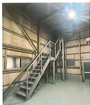
新設階段正面
